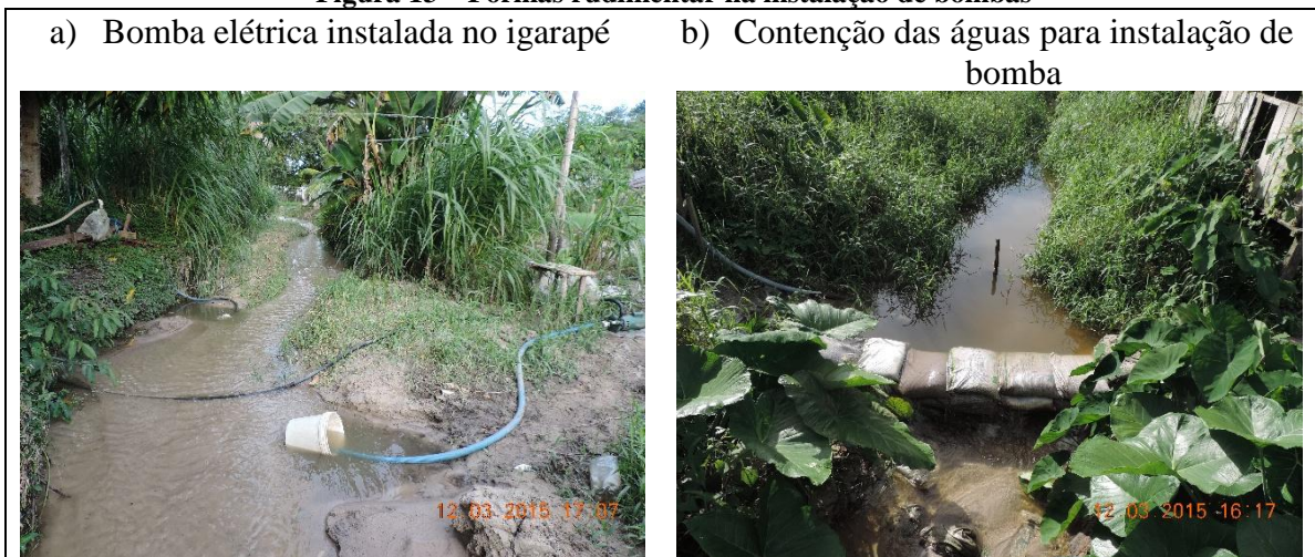
Figura 13 – Formas rudimentar na instalação de bombas
